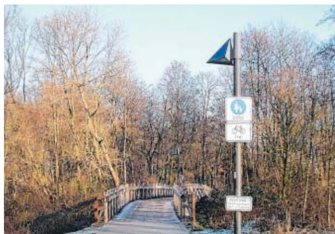
Umleitung: Während die Brücke auf Höhe der Freilichtbühne gesperrt ist, wird eine Umleitung über die neue Almebrücke zwischen Almering-Parkplatz und „Im Schlosspark“ ausgeschildert. FOTO: TP
